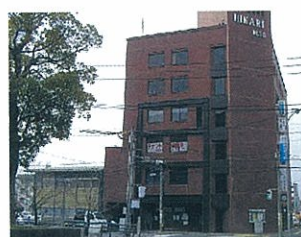
事務所ビル施工例
