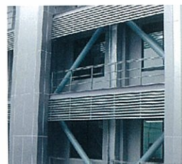
従来型補強(高性能ブレース)
