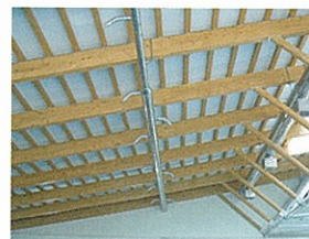
温水プール屋根(スパン17m)
