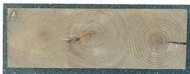
芯持ち角材による接着重ね梁の断面
