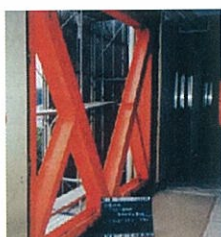
大断面H形鋼による補強例
