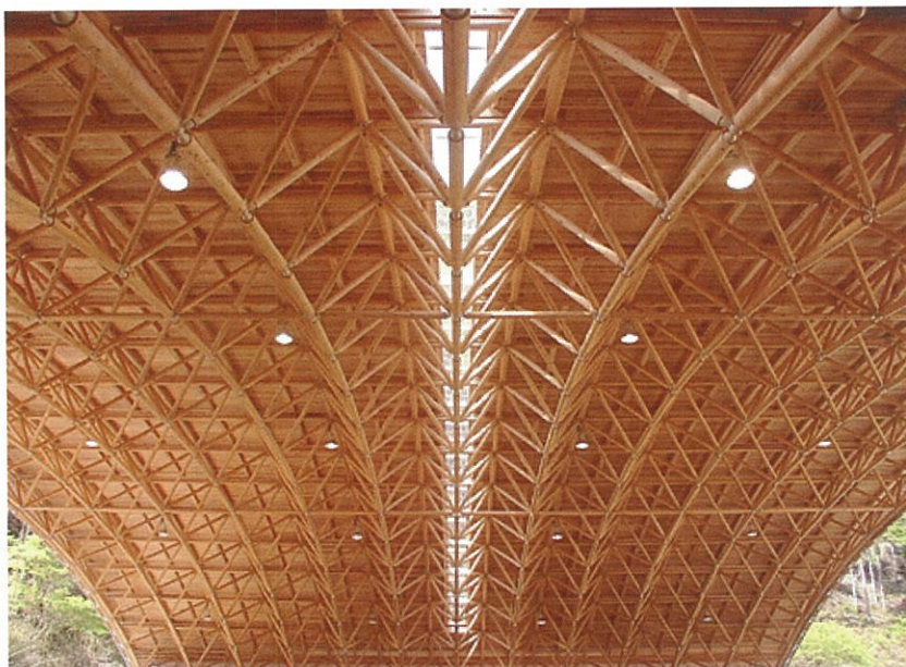
小中径（丸太）によるスペースフレーム（山崎町生涯学習センター「学遊館」）
